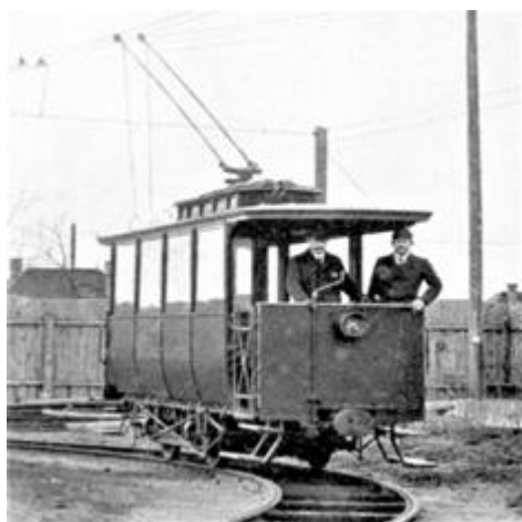
7. ábra: Kandó aszinkron motoros kísérleti kocsija
